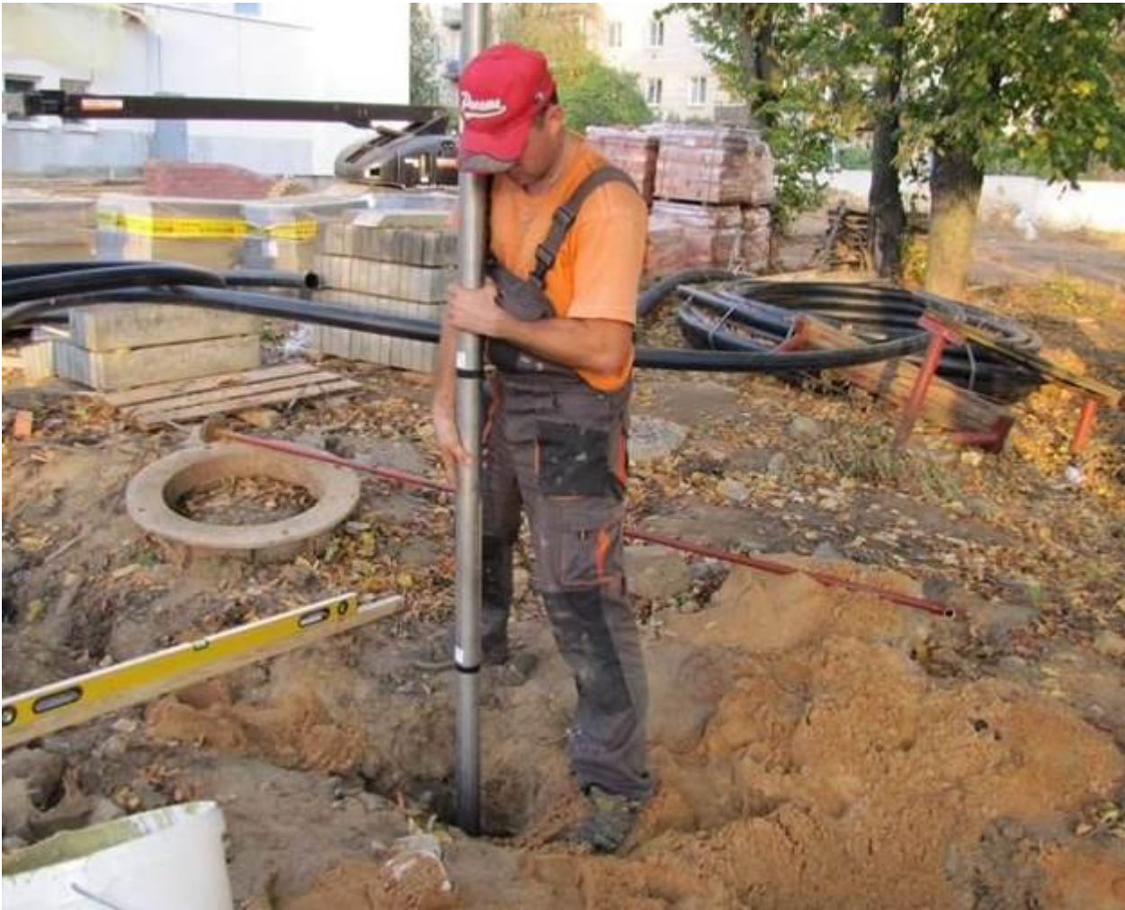
Рисунок 4. Монтаж 3-х метрового вертикального электролитического заземлителя.
