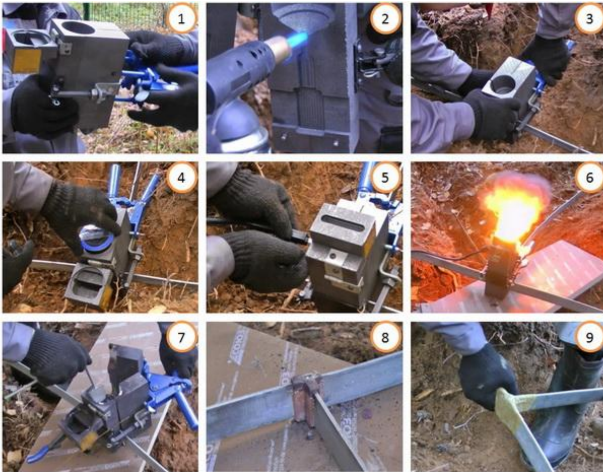
Рисунок 4. Порядок выполнения термитной сварки
