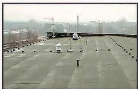
Крыша покрытая битумной гидроизоляцией
