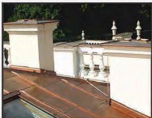
Историческое здание, фальцевая медная кровля
