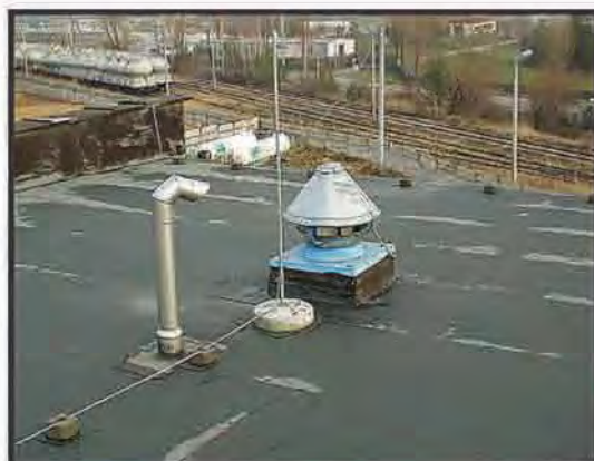
Промышленный объект, свободно стоящий молниеприемник
