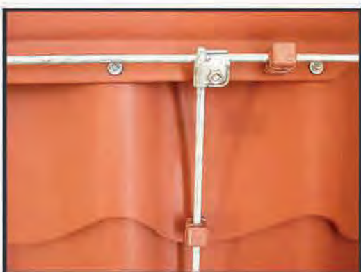
Металлочерепица - проводка оцинкованная
