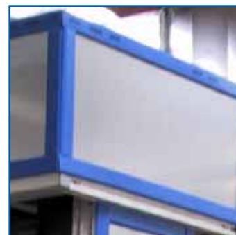
Материал коробов – листовой алюминий, степень защиты – от IP 20 до IP 54
