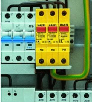
Рис.1. УЗИП класса I PIII280 установленные в РЩ.
