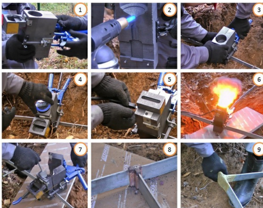
Рисунок 4. Порядок выполнения термитной сварки
