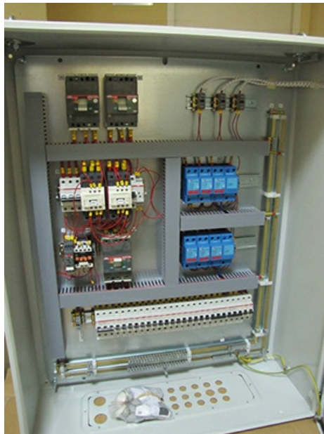
Рисунок 3. ЩЗИП-АВР-50-21 совмещает в себе функции автоматического ввода резерва и защиты от импульсных перенапряжений.
