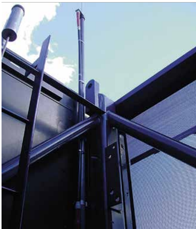
Рисунок 14. Пример прокладки изолированного токоотвода по металлическим конструкциям защищаемого объекта.
