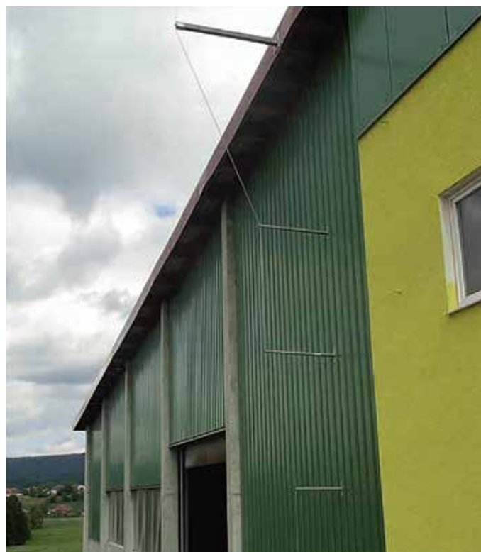
Рисунок 6. Токоотвод, проложенный с учётом соблюдения безопасного расстояния от защищаемого объекта.
