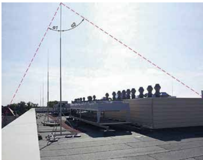
Рисунок 12. Пример использования метода защитного угла.
