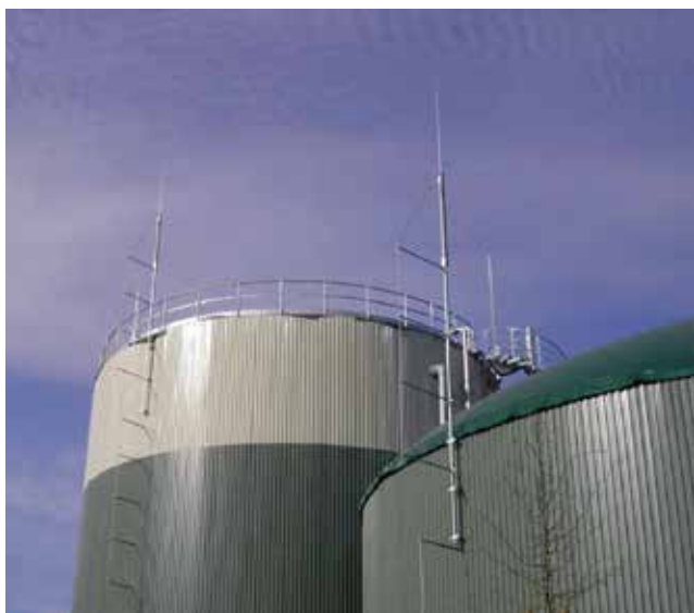
Рисунок 5. Использование многократных молниеприёмников по внешней окружности защищаемого объекта.
