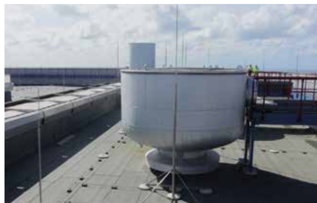
Рисунок 3. Использование стержневых молниеприёмников для защиты кровельных надстроек.
