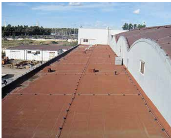
Рисунок 15. Использование молниеприёмной сетки.
