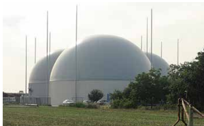
Рисунок 2. Использование отдельно стоящих молниеотводов.
