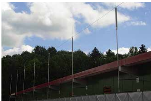
Рисунок 4. Использование тросового молниеприёмника в комбинации с многократными стержневыми молниеприёмниками, установленными на защищаемом объекте.
