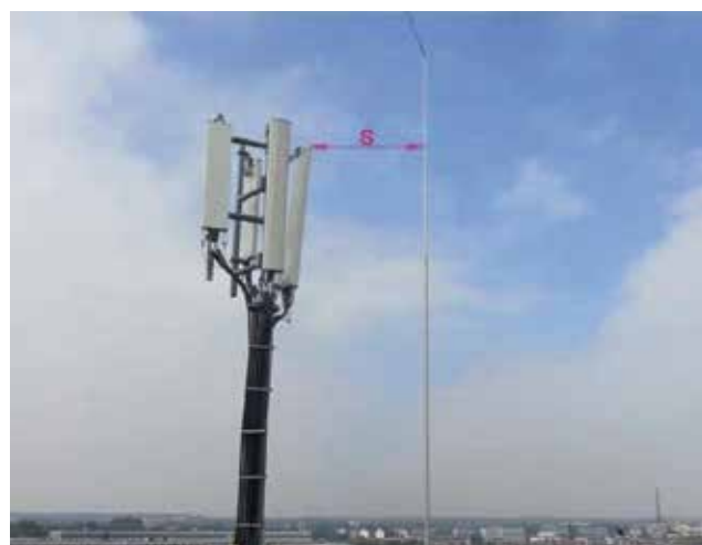
Рисунок 13. Пример использования безопасного расстояния.
